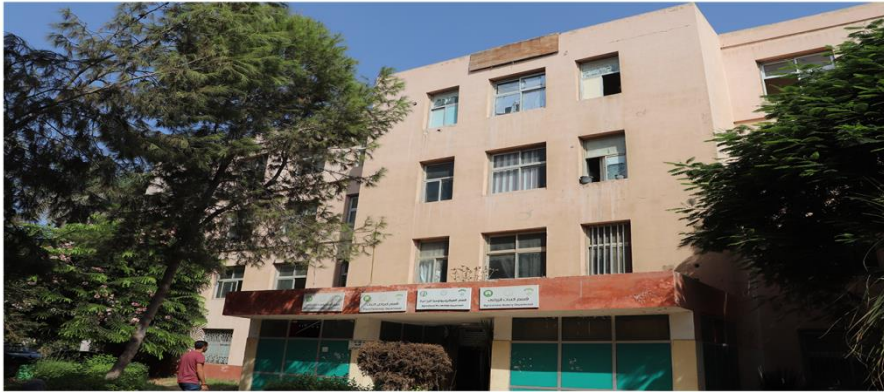
مبنى النبات الزراعي
